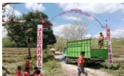
Gambar 1.14 Pemasangan Gapura di simpang jalan masuk desa
