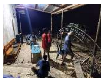
Gambar 1.15 Pengelasan tulisan di rangka gapura
