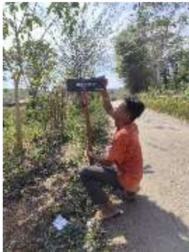
Gambar 1.17 Pemasangan plang desa
